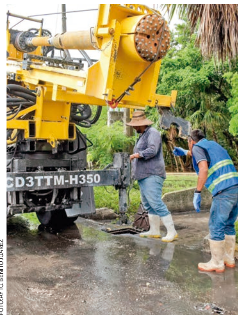
Personal de Servicios Públicos trabaja para desazolver encharcamientos por las intensas lluvias que se registraron el fin de semana en diversas colonias y avenidas de Benito Juárez.
