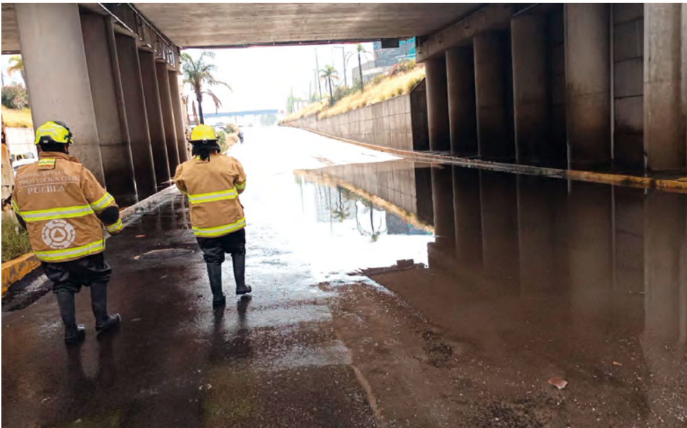
La circulación permaneció restringida mientras se efectuaban los trabajos de atención.
